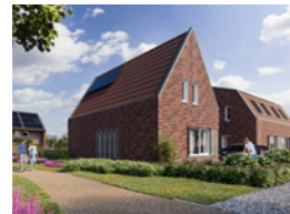
Levensloopbestendige halfvrijstaande woning Bouwnummer 26
